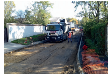
Cette photo a été prise pendant le chantier.
