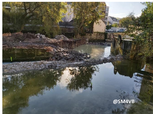
Travaux de renaturation de l'Almont Rue des Trois Moulins (SM4VB, 2022)
